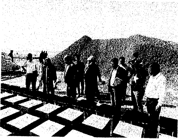
চলমান কাজের জন্য প্রস্তুতকৃত ব্লকের সাইট পরিদর্শন
