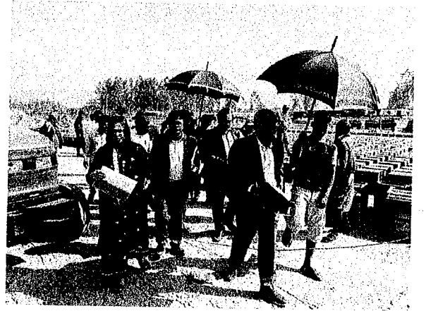
চলমান কাজের জন্য প্রস্তুতকৃত ব্লকের সাইট পরিদর্শন
