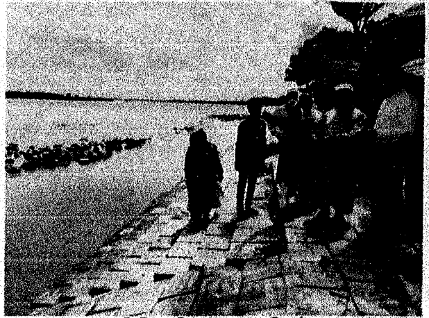
নদীতীর প্রতিরক্ষা কাজ পরিদর্শন
