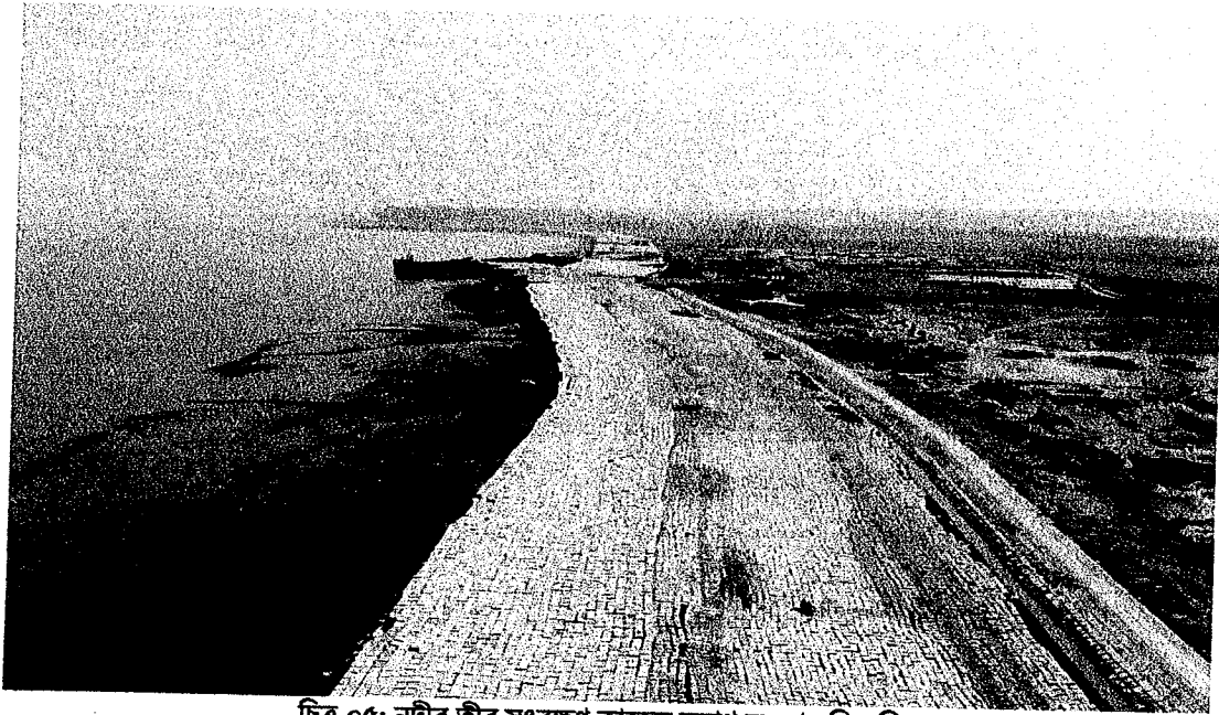
চিত্র-০৫: নদীর তীর সংরক্ষণ কাজের সমাপ্ত অংশের স্থির চিত্র
