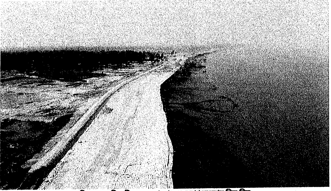
চিত্র-০৬: নদীর তীর সংরক্ষণ কাজের সমাপ্ত অংশের স্থির চিত্র
